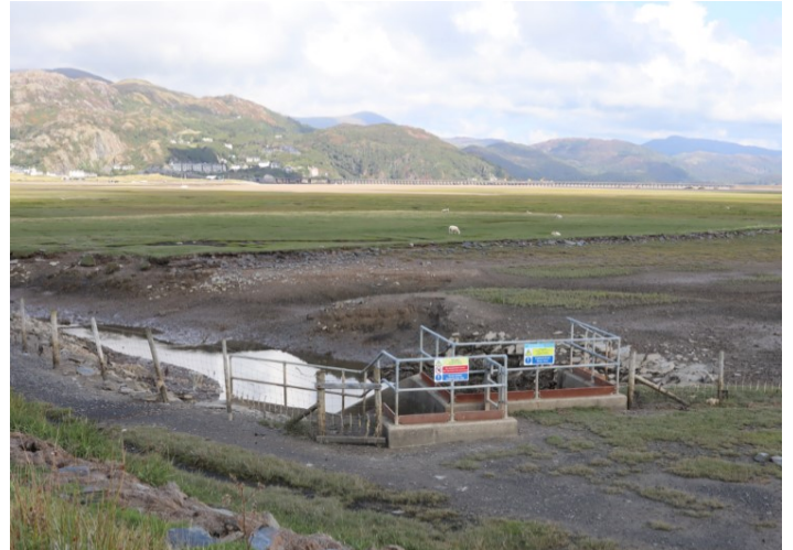
Ffigur 38: Gât lanw wrth ymyl clwb golff Fairbourne wrth geg y rhwydwaith ffosydd draenio. (chwith) Mewnfa o sianel y nant (dde) Allfa i'r aber.
