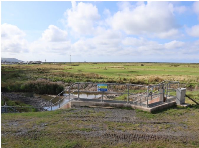
Ffigur 38: Gât lanw wrth ymyl clwb golff Fairbourne wrth geg y rhwydwaith ffosydd draenio. (chwith) Mewnfa o sianel y nant (dde) Allfa i'r aber.
